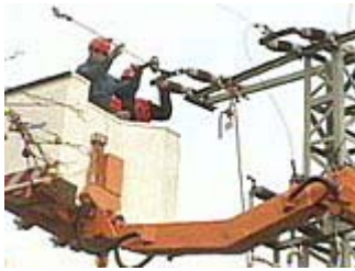
Reparaturarbeiten an Stromleitung
