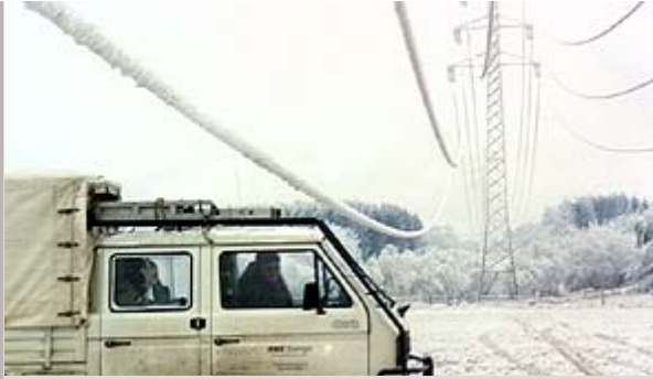
Vereiste Hochspannungsleitungen
