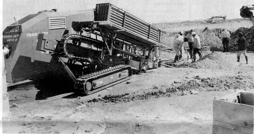
Der Terra-Jet 6015 D in Arbeitsstellung: Gut zu erkennen ist die Bohrung von der Oberfläche.
