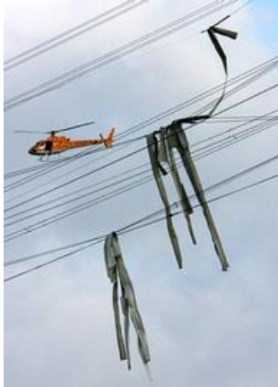
Teile eines Daches hängen in den Stromleitungen
