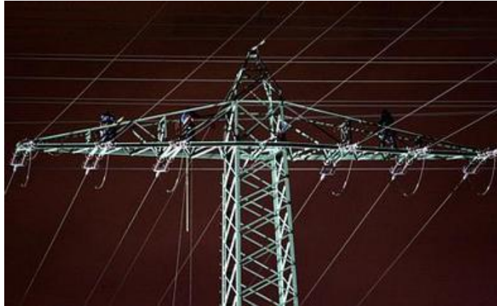
Spezialisten bei Reparaturarbeiten an den Stromleitungen
